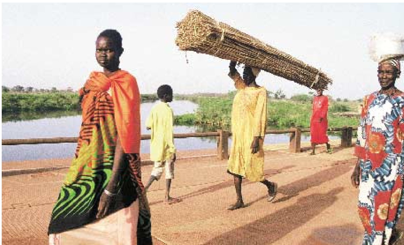
Bro över floden Bahr el Ghazal, södra Sudan, byggd av Lundin Sudan Limited
