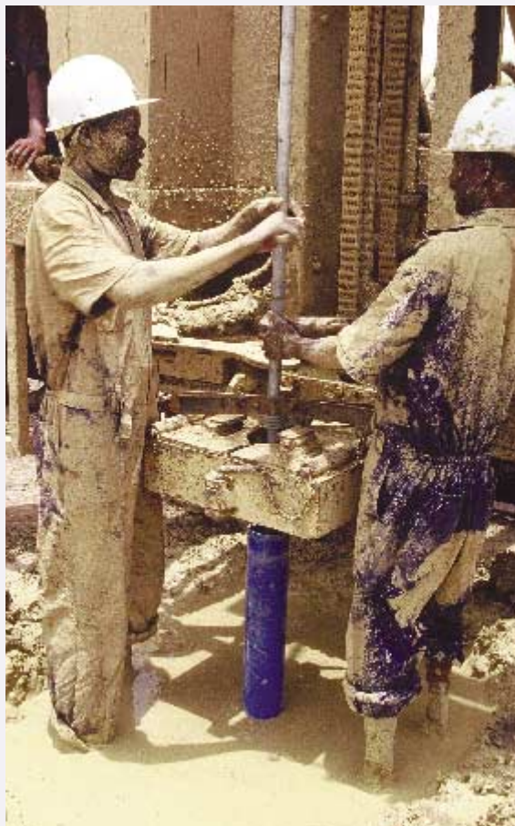
Borrning av vattenbrunn utmed "allvädersvägen" mellan Rubkoena och Thar Jath (Block 5A i Sudan) bekostad av Lundin Sudan Limited
